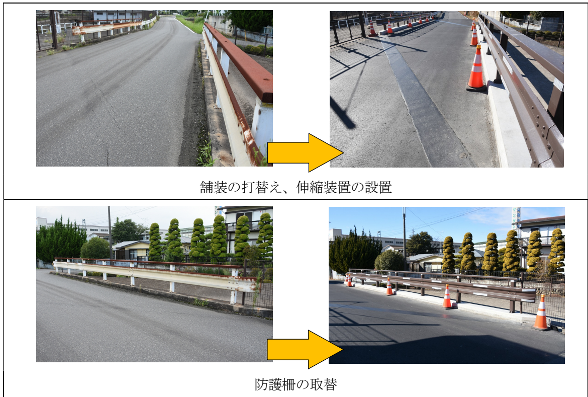
図-2 修繕の実施状況の一例
