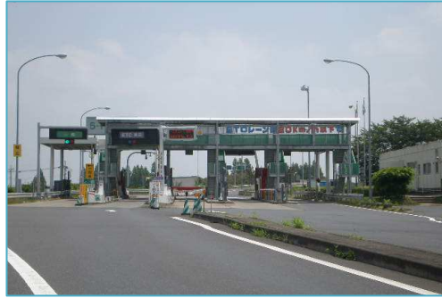
羽生インターチェンジ
