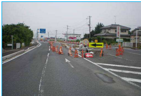
国道 122 号(4車線化整備中)
