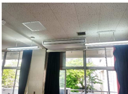
中学校特別教室空調機設置工事
