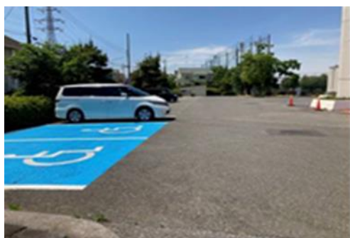
駐車場区画線修繕
