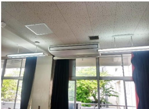
中学校特別教室空調機設置
