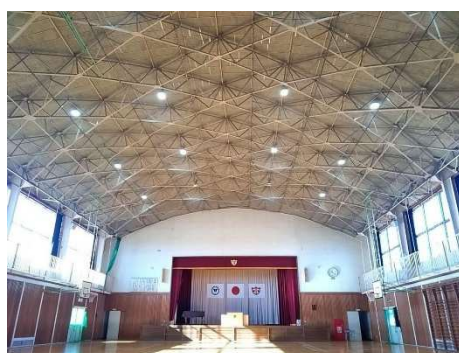
工事が完了した須影小学校体育館
