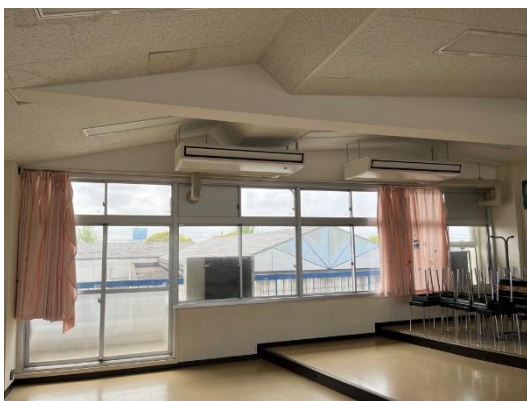
工事が完了した特別教室の空調機
