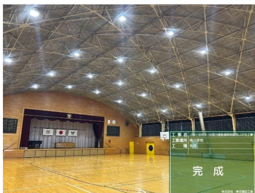
工事が完了した羽生南小学校体育館
