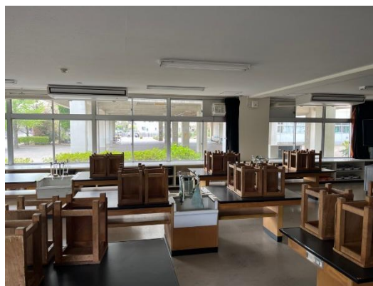
工事が完了した特別教室の空調機
