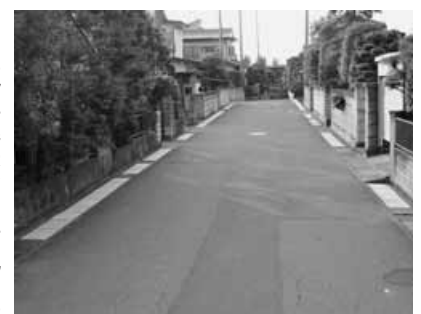
側溝蓋布設が完了した東9丁目地内の道路
