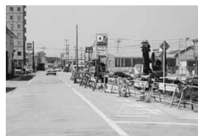
整備中の上西口・中岩瀬線 (都市計画道路)
