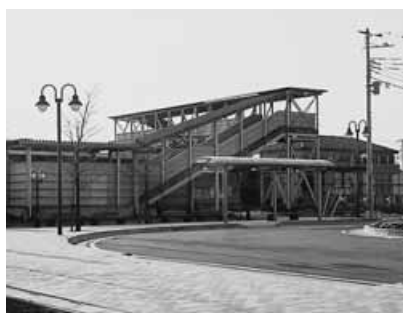
南羽生駅東口駅前広場
