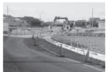
道路改良工事(その3)市道0105号線(下岩瀬・小松地内)
