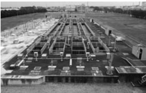
羽生市水質浄化センター
