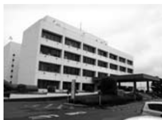
羽生市役所庁舎
