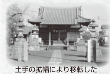
土手の拡幅により移転した現在の長良神社
