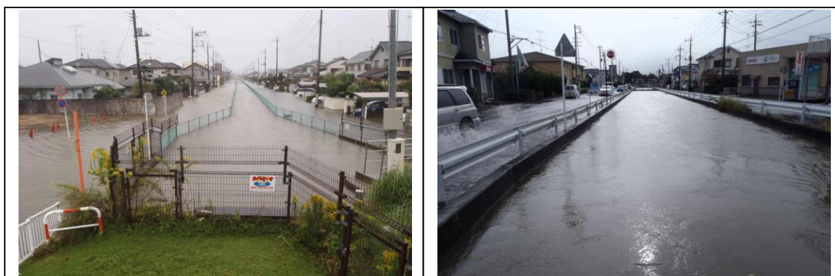
(宮田落排水路)
