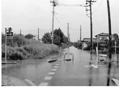
南中学校周辺の道路冠水
