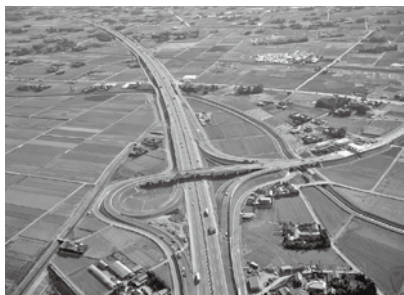
羽生インターチェンジ
