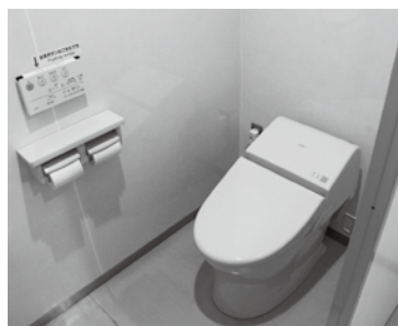
改修した洋式トイレ
