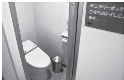
市庁舎トイレに設置されたサニタリーボックス
