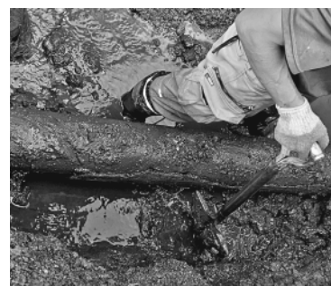
漏水した水道管の修繕工事
