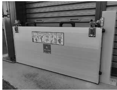
浸水を防ぐ止水板
