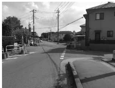
今後の整備予定の井泉中央道路
