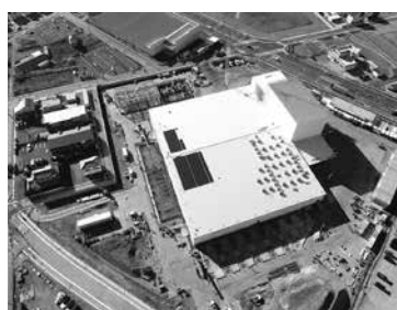
建設が進んでいる丸和油脂の工場
