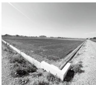
上村君地区の改修された排水路
