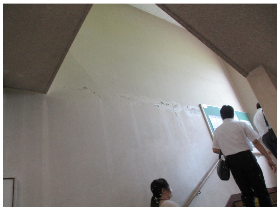
校舎内壁ひび割れ
