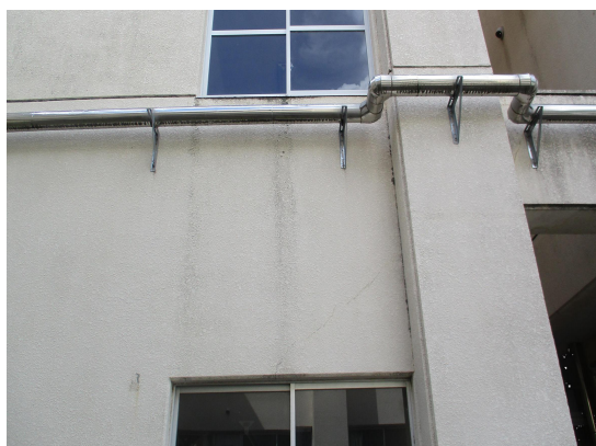
校舎外壁ひび割れ
