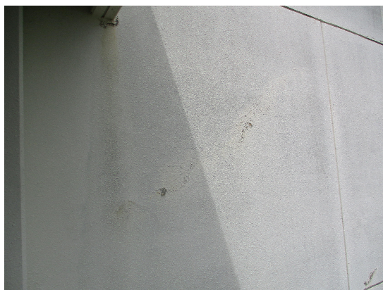
校舎外壁ひび割れ
