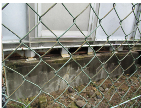
受水槽老朽化・土台腐食
