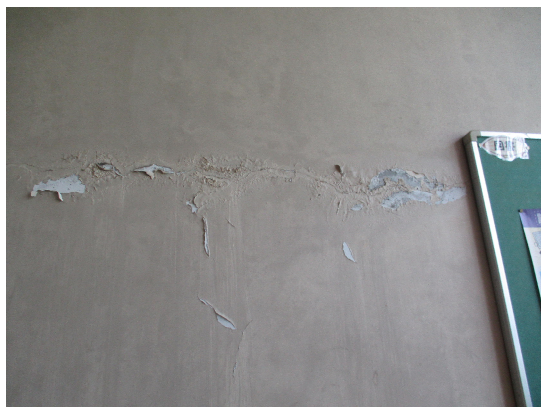
校舎内壁ひび割れ
