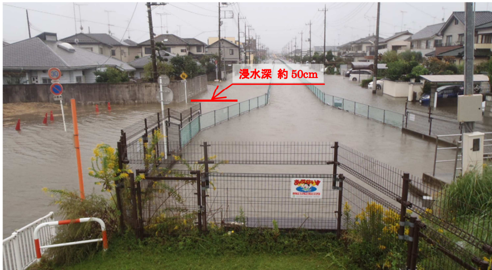
写真③:宮田落伏越上流部
